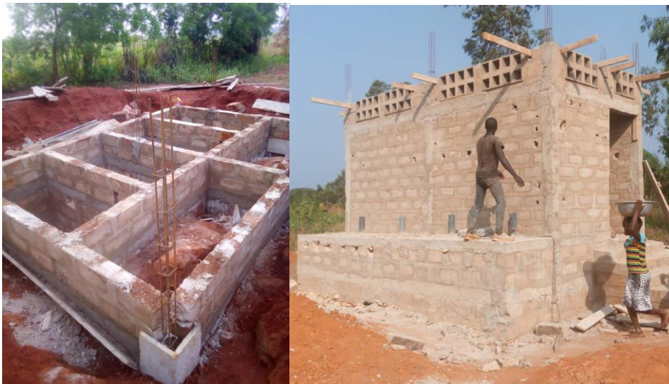
Les latrines en construction
