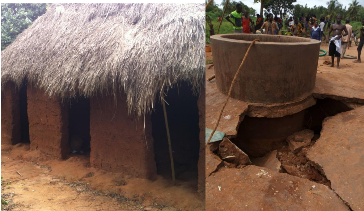
Les latrines de l'école de Badjénopé
