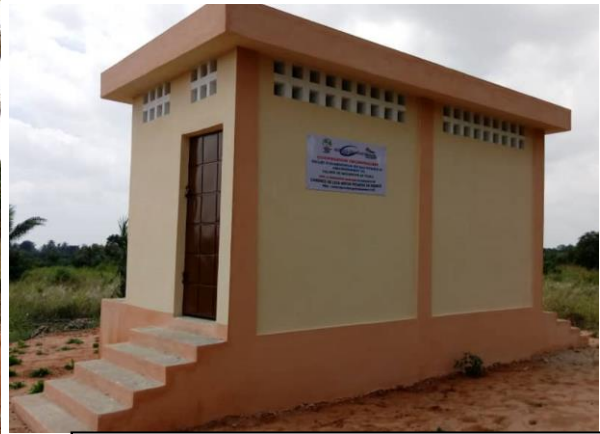
Latrine dans le Collège d'enseignement Général de Badjénopé
