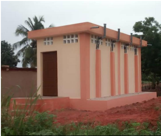
Latrines dans l'école primaire Groupe C
