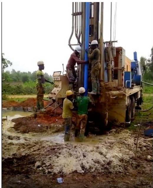
Travaux de forage
