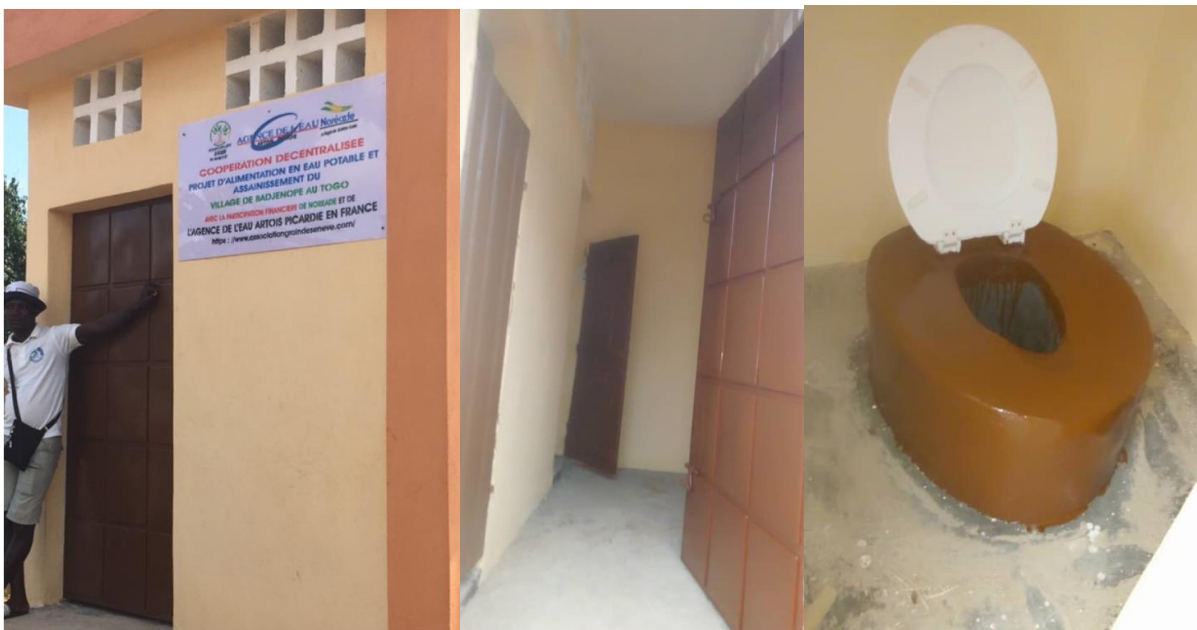
Vue de l'intérieur. Travaux de construction terminés
