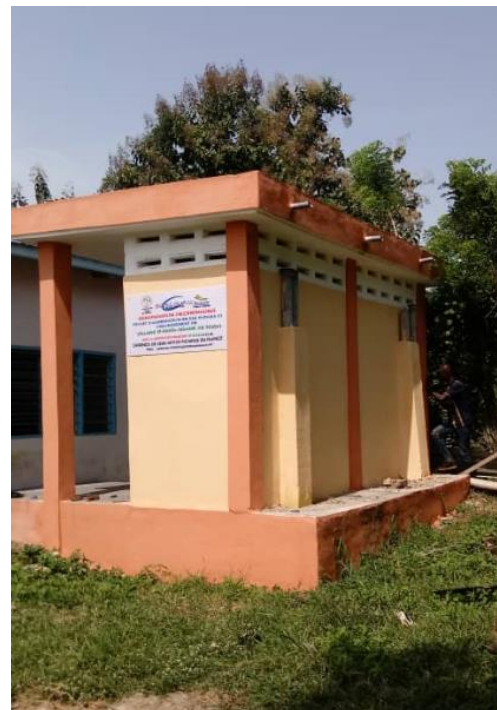
Latrine du Collège d'Enseignement Général d'Akata
