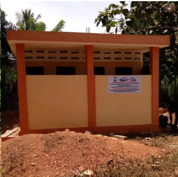
Latrine dans le Centre de Santé d'Akata
